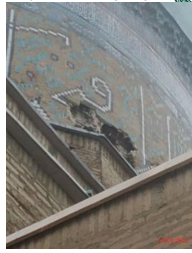
7-rasm. Iqlim ta'sirida barabanda hosil bo'lgan deformatsiya va yoriqlar
