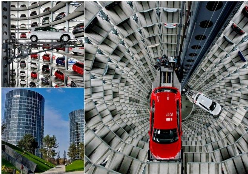
7-rasm. 400 o'rinli ko'p qavatli yopiq avtomatlashtirilgan saqlash binosi (Germaniya, Wolsburg, Cilinder Parking avtosaqlash tizimi).
