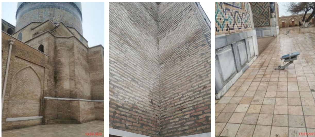
6-rasm. Yog'ingarchilik suvlarining masjid devorlari holatiga ta'siri
