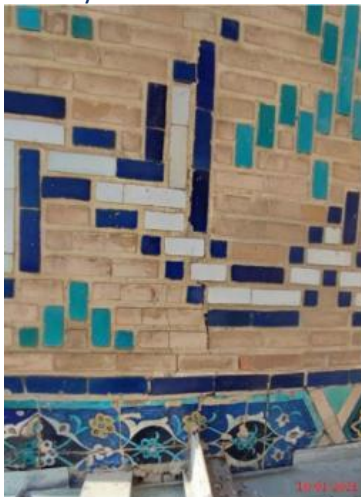
7-rasm. Iqlim ta'sirida barabanda hosil bo'lgan deformatsiya va yoriqlar
