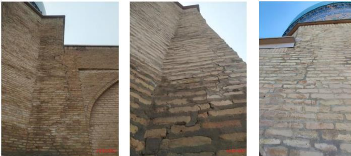
5-rasm. Masjid binosining tashqi devorlaridagi yoriqlar
